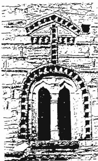
Εἰκ. 16. Λακωνία, ναὸς Κοιμήσεως Θεοτόκου στὰ Χρύσαφα. Χαρακτηριστικὰ εἶναι τὰ τοξὺλια διπλῆς καμπυλότητας στὰ παράθυρα τῆς ἀνατολικῆς πλευρᾶς, ὅπως φαίνεται καὶ στὴν εἰκόνα μας (Καρυώτου).
